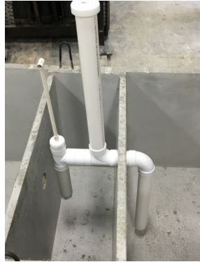
Orenco Biotube Effluent Filter
