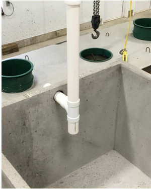
Inlet Baffle
